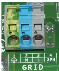
Fig. 11 - Morsetti per connessione cavi AC
